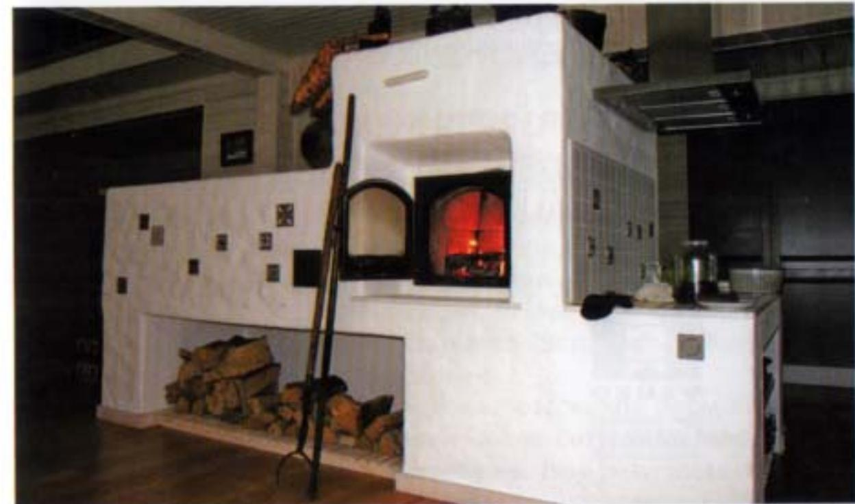
В нашей печи дым из горнила попадает в дымоходы, устроенные в объеме лежанки, которая перекрыта талькохлоритными плитами для большего накопления тепла. Нагрев лежанки регулируется шибером – это важно: предотвращается её перегрев. Поэтому выше приведённый случай с загоревшимися тряпками стал аргументом для замены нами той исторической Русской печи на описываемую современную.
